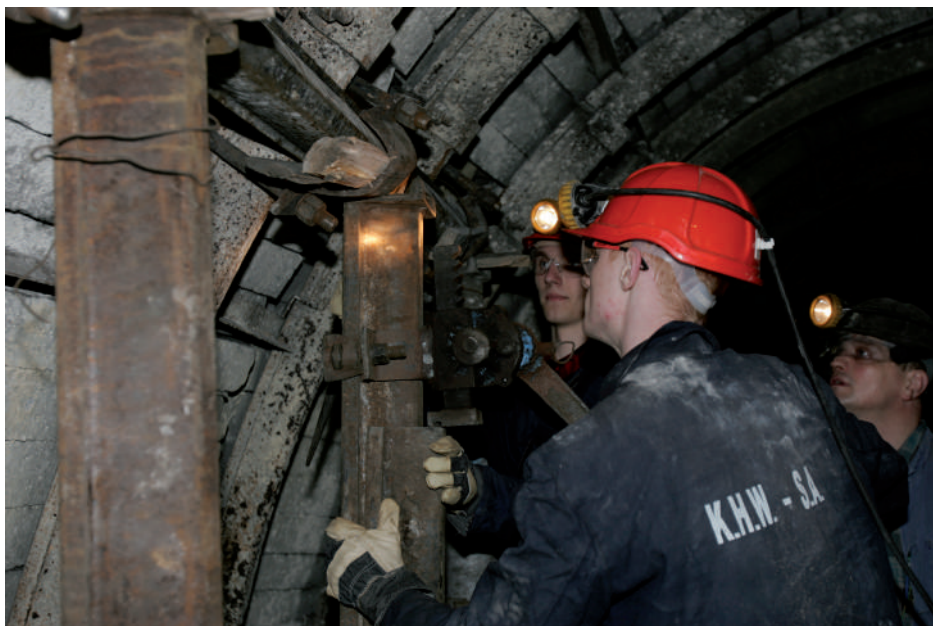
Rys. 2. Budowa przez uczniów stojaków stalowych typu SV
