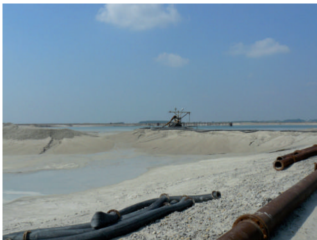
Fot. 4. Kwatera na składowisku w końcowym etapie formowania grobli zamykającej
