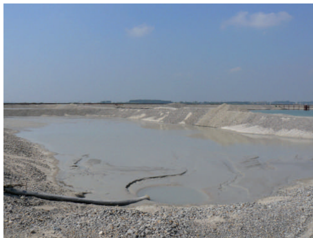
Fot. 5. Kwatera w trakcie wypełniania odpadami
