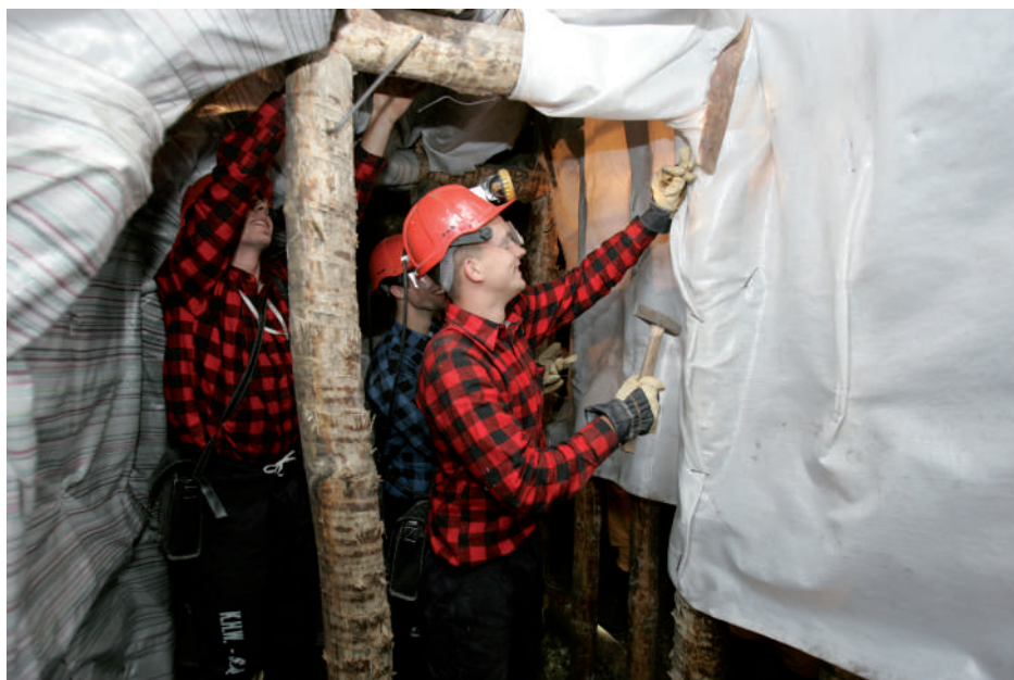
Rys. 3. Uczniowie na stanowisku budowy tamy podsadzkowej
