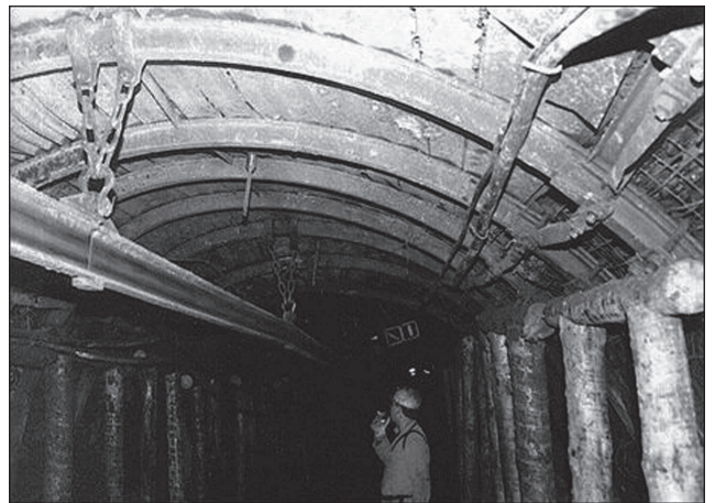
Rys. 6.4. Wzmocnienie górotworu poprzez wysokie kotwienie wyraźnie zmniejsza deformacje obudowy
