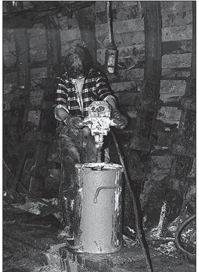
Rys. 5.1. Przygotowanie spoiwa cementowego do wklejania kotwi linowych
