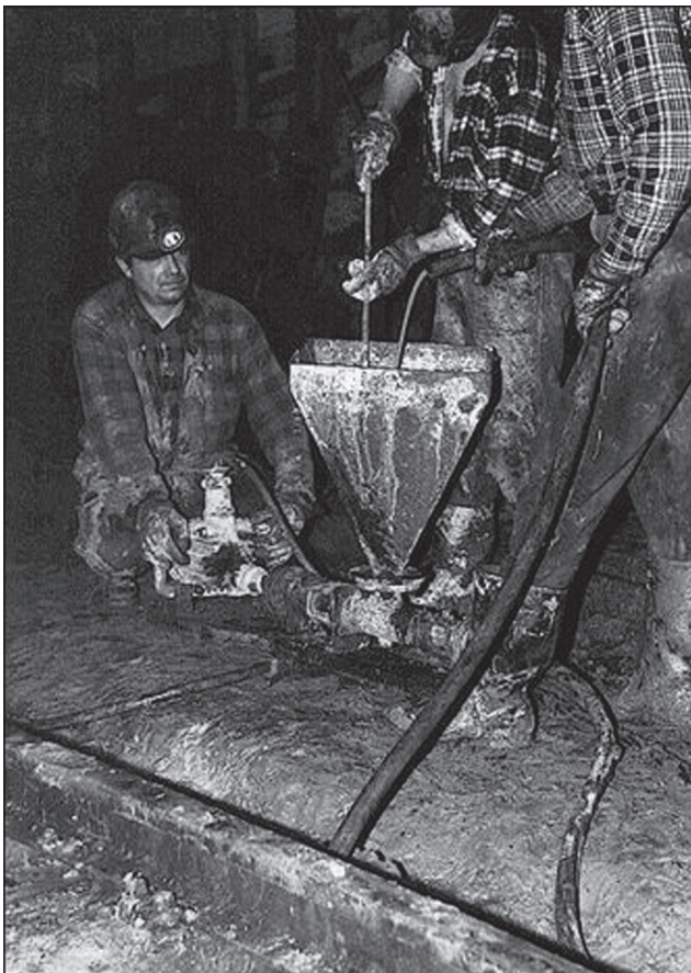
Rys. 5.2. Pompa do zatłaczania spoiwa cementowego
