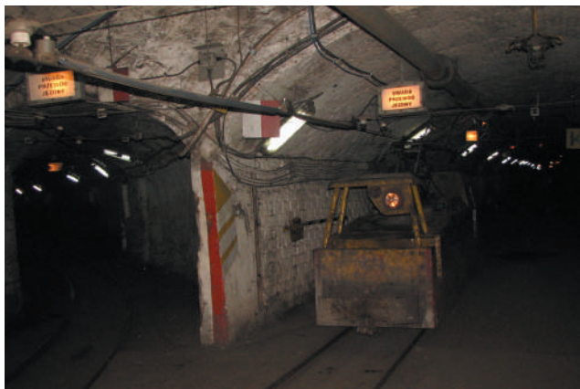
Rys. 16. Podgląd na rejon przy pomieszczeniu głównego dysponenta przewozu w rejonie szybu
