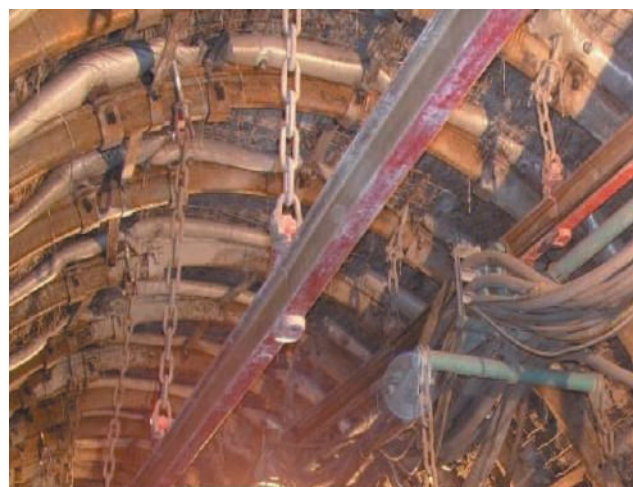
Fot. 2. Fragment wyrobiska z wykładką mechaniczną
