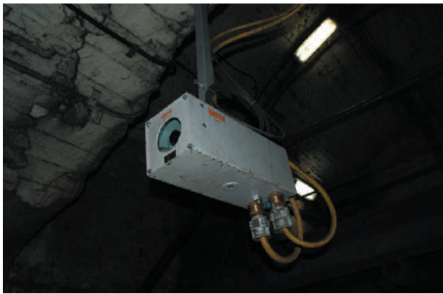
Rys. 3. Kamera dołowa zainstalowana na podszybiu szybu „Helena”, poz. 500 m
