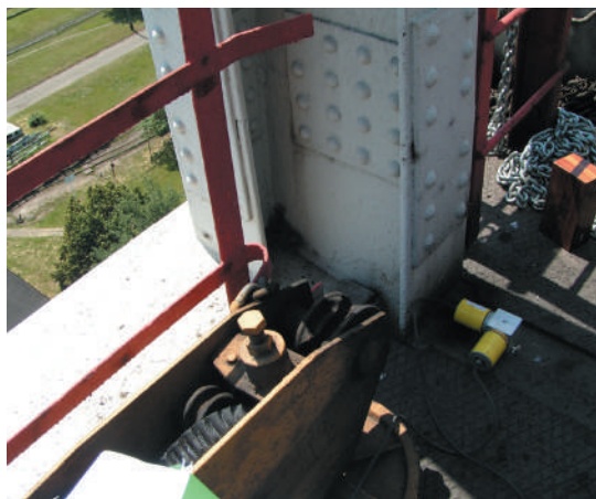
Rys. 3.1. Punkt pomiarowy w poziomie kół górnych – poz. +36,5 m, czujniki 17x, 18y
