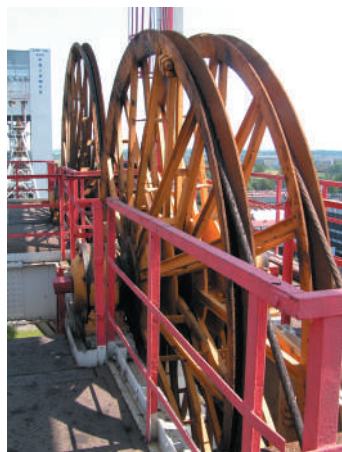
Rys. 2.2. Widok na koła wyciągowe w poziomie +36,0
