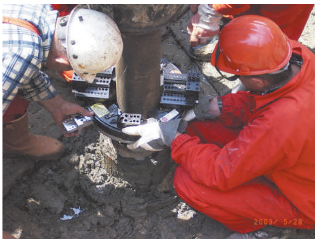
Fot. 2. Montaż noża
