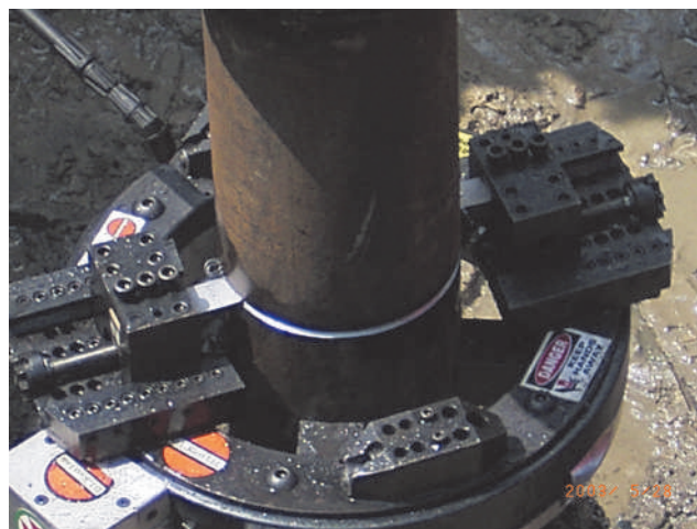
Fot. 3. Cięcie rury 95/8. Fazowanie powierzchni czołowej rury
