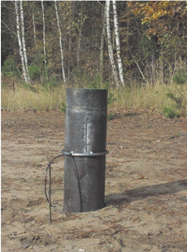
Fot. 6. Przygotowanie stanowiska do próbnego ucinania rury okładzinowej
