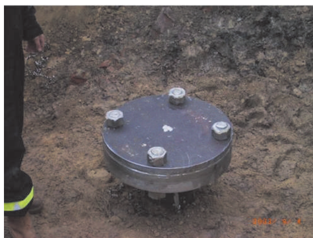
Fot. 5. Montaż dekla
