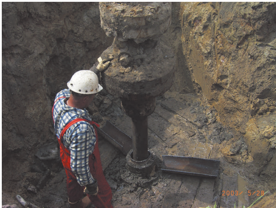
Fot. 1. Wycinanie odkopanych rur okładzinowych
