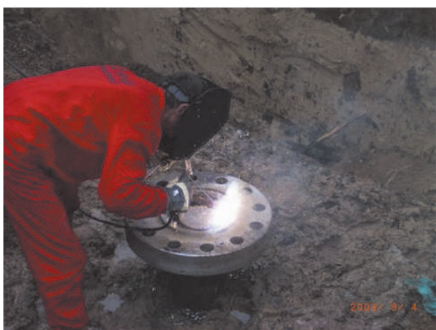
Fot. 4. Spawanie kryzy bazowej do rury
