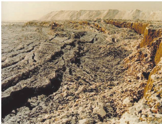
Rys. 5. Zerwa na poziomie roboczym Z-42 (poz. +415)
