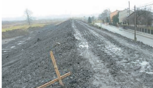
Rys. 7.2. Budowa wału przeciwpowodziowego w miejscowości Gromiec na rzece Wiśle z wykorzystaniem skały płonnej pochodzącej z ZG „Janina” w Libiążu
