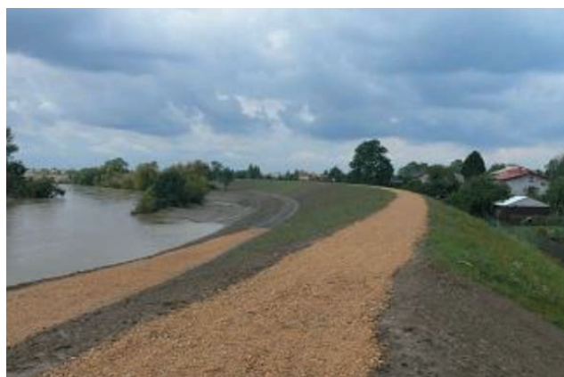
Rys. 7.4 Wybudowany wał przeciwpowodziowy w miejscowości Gromiec na rzece Wiśle wykonany ze skały płonnej pochodzącej z Zakładu Górniczego „Janina” w Libiążu
