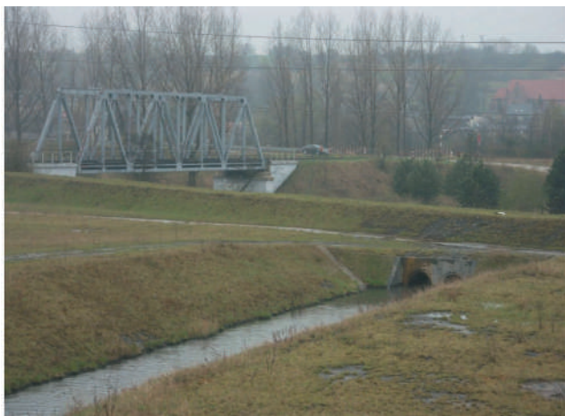
Rys. 12. Rzeka Przemsza - wały przeciwpowodziowe, kanał odprowadzający wody z osadnika przez zawale
