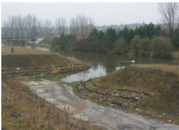
Rys. 11. Rzeka Przemsza - wały przeciwpowodziowe
