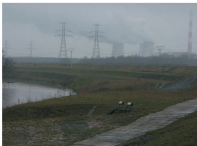
Rys. 9. Rzeka Przemsza - wały przeciwpowodziowe
