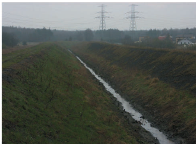
Rys. 13. Potok Wąwolnica - wały przeciwpowodziowe
