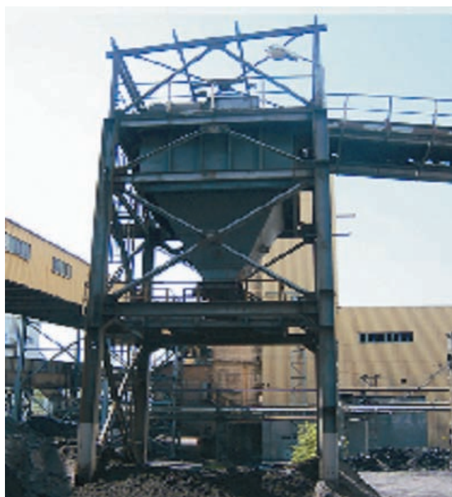
Rys. 7.5. Miejsce załadunku kruszywa o frakcji 0-2 mm, 2-30 mm oraz 0-30 mm w ZG „Sobieski”
