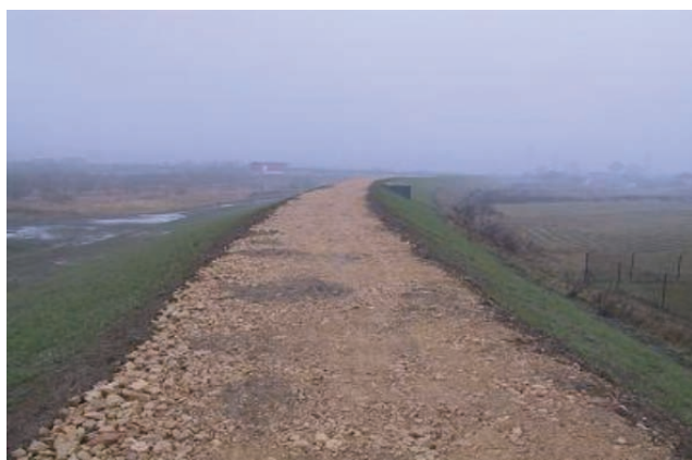
Rys. 7.3. Wybudowany wał przeciwpowodziowy w miejscowości Bobrek na rzece Wiśle wykonany ze skały płonnej pochodzącej z Zakładu Górniczego „Janina” w Libiążu
