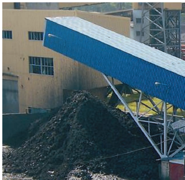
Rys. 6.3. Muły w postaci placków w miejscu załadunku na samochody dla elektrowni PKE S.A.
