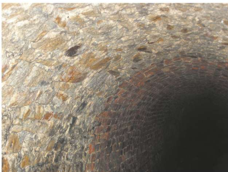
Rys. 9. Odcinek sztolni z obudową murową
