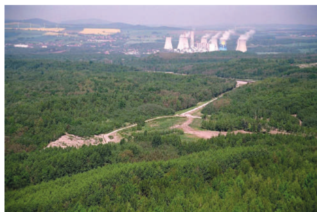
Rys. 36. Elementy hydrotechniczne na zwałowisku zewnętrznym
