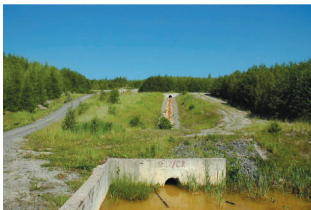
Rys. 33. Rekultywacja terenów pogórnicych. Zwałowisko zewnętrzne – płyta lotniska
