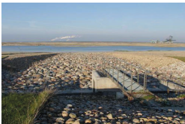
Rys. 15. Napełnianie zbiornika wodnego „Przykona”
