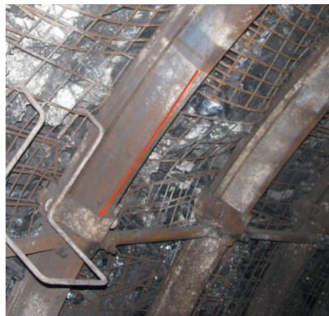
Rys. 6. Deformacje konturu chodnika Cw-1 badawczego a) zmiana przekroju poprzecznego wyrobiska, b) zsuw na zamkach obudowy – ocios lewy
