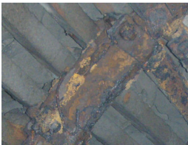
Rys. 3. Korozja szczelinowa
