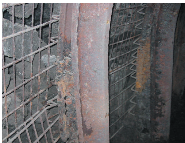
Rys. 4. Korozja wżerowa
