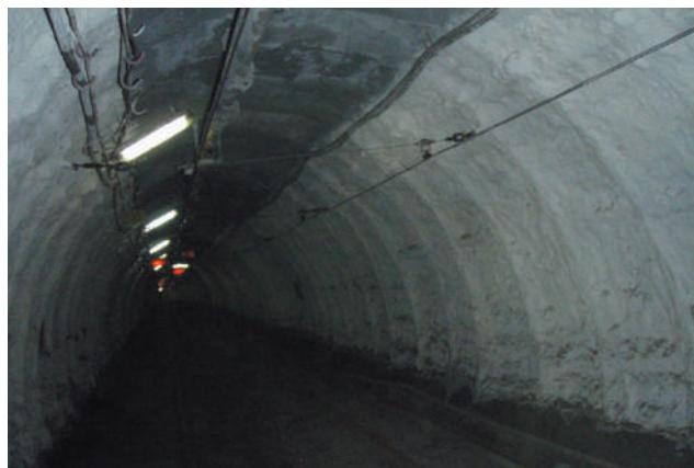
Rys. 11. Wyrobisko korytarzowe w obudowie LP po dokonaniu wzmocnienia warstwą betonową natryskową
