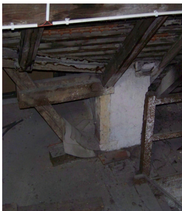
Fot.6.2 Odspojenie konstrukcji murowanej nadbudówki od krokwi
