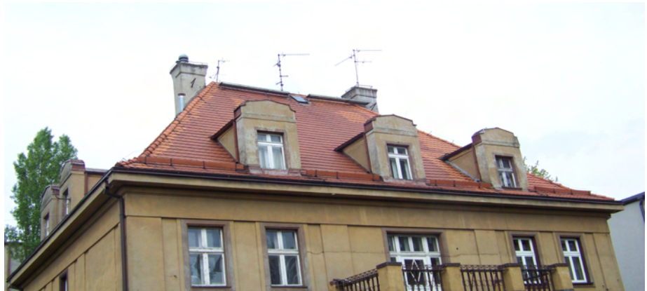
WIDOK DACHU OD POŁUDNIOWEGO ZACHODU
