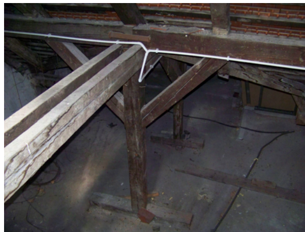
Fot.5.4 Widok płatwi opartej na słupkach oraz kleszczy
