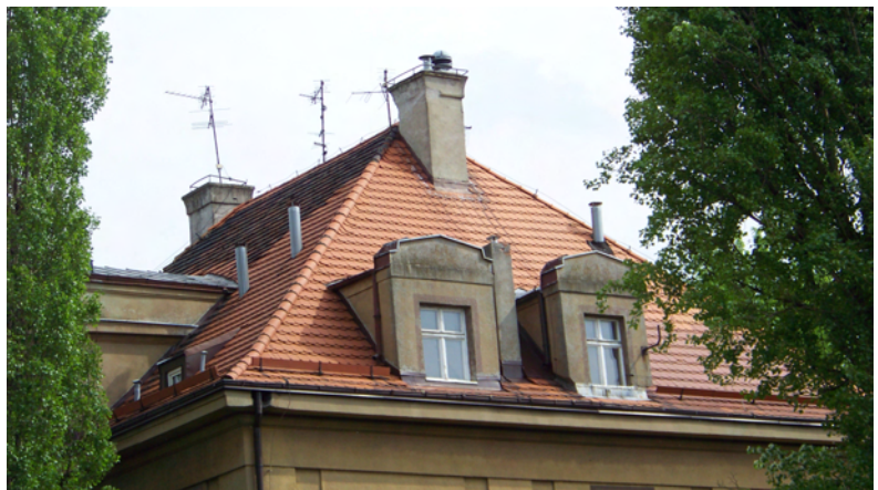
WIDOK DACHU OD PÓŁNOCNEGO ZACHODU
