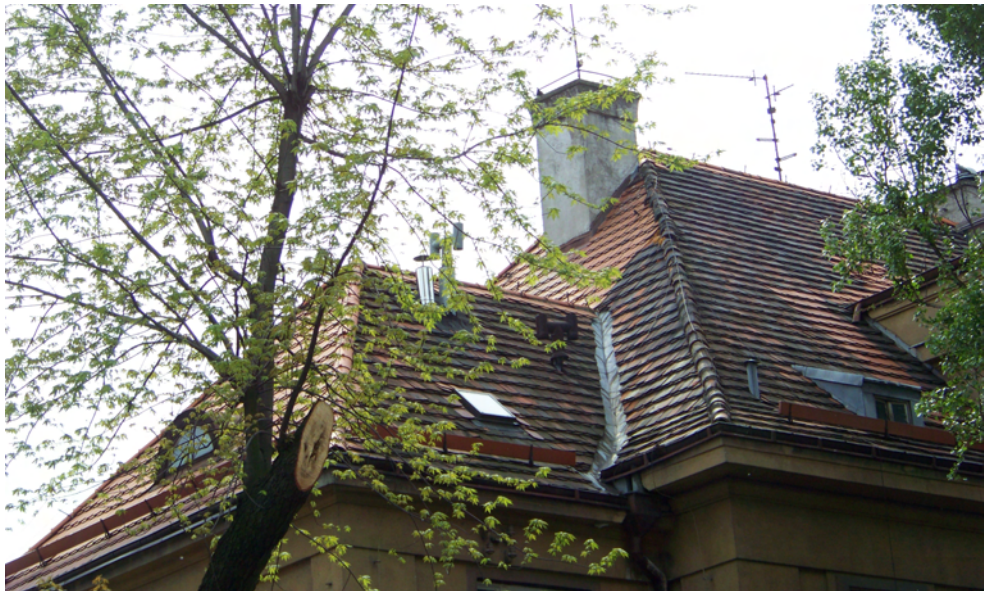
WIDOK DACHU OD PÓŁNOCNEGO WSCHODU
