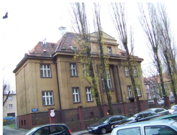
Fot.5.2 Widok ogólny budynku – elewacja od strony ulicy Poniatowskiego
