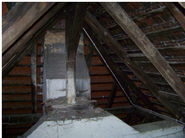
Fot.5.3 Widok ogólny więźby dachowej
