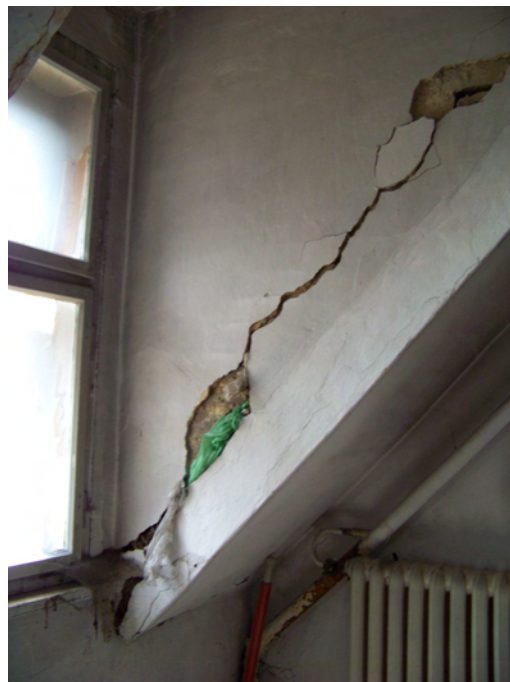
Fot.6.2 Odspojenie konstrukcji murowanej nadbudówki od krokwi
