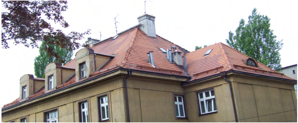
WIDOK DACHU OD POŁUDNIOWEGO WSCHODU
