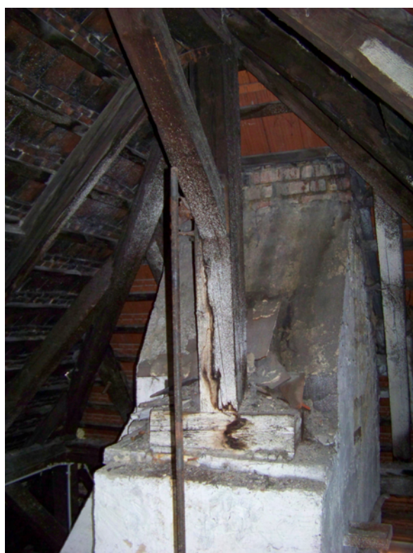
Fot.6.3 Widok korozji biologicznej na słupie
