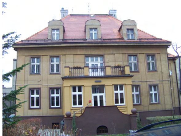
Fot.5.1 Widok ogólny budynku – elewacja tylna z wejściem
