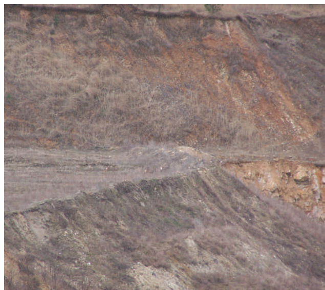
Fot. 2.2. Niski wał ziemny usytuowany bezpośrednio przy brewce skarpy
