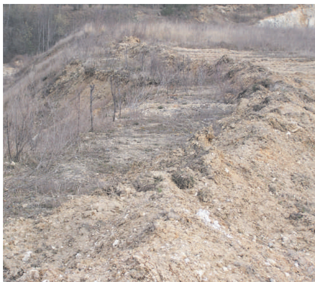
Fot. 2.1. Niski wał ziemny usytuowany w odległości ok. 2 m od brewki skarpy
