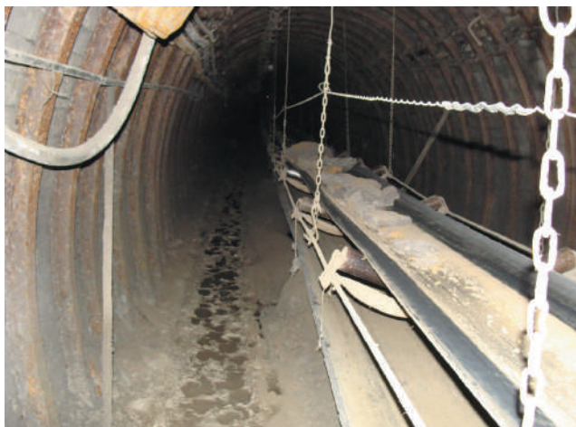
Fot. 2. Upadowa wydobywcza z przenośnikiem taśmowym PTG-32/800
