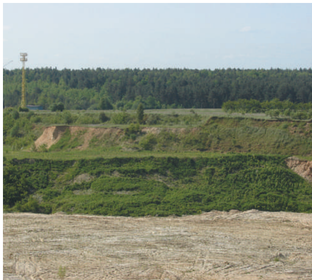
Fot. 3.3. Skarpa po ustabilizowaniu przy współudziale mieszanki traw z lucerną (na pierwszym planie obszar spągu przed zagospodarowaniem)
