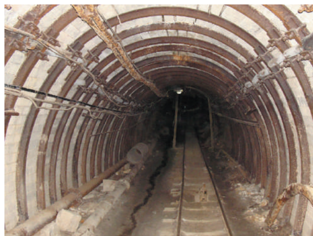
Fot. 3. Upadowa materiałowa wyposażona w tory, z lewej rurociągi wodne
