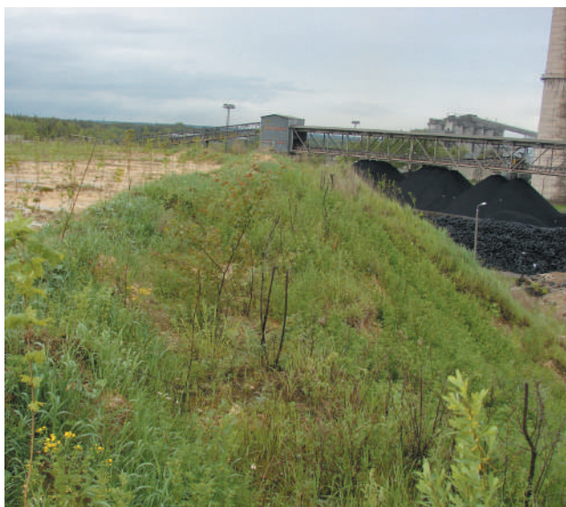
Fot. 3.1. Skarpa zabezpieczona wałem ziemnym przed spływem wody z wierzchowiny, obsadzona drzewami i obsiana mieszanką traw i roślin motylkowych
