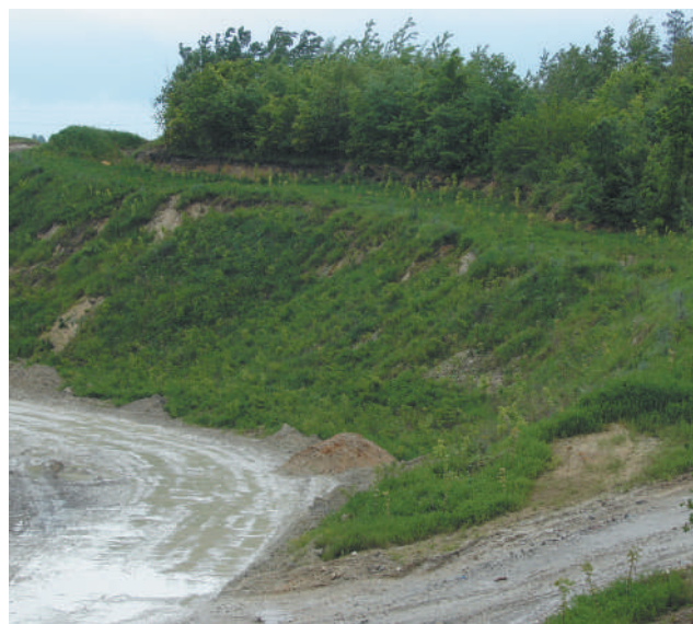
Fot. 3.2. Wielogatunkowy zespół roślinny na zrehabilitowanej skarpi
