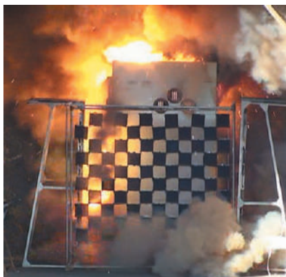
Fot. 2. Rozdzielnica podczas badań na skutki wewnętrznego zwarcia łukowego: 25kA/1sekundę
