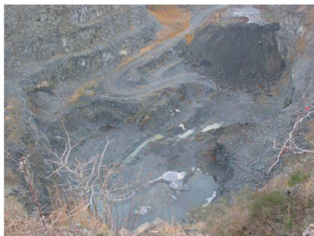
Fot. 1.2. Wyrobisko przed rekultywacją – widok z powierzchni terenu
