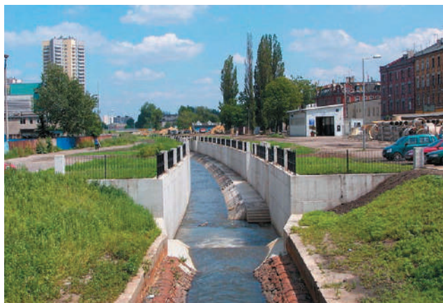
Rys. 5. Rzeka Rawa w śródmieściu Katowic po rewitalizacji
