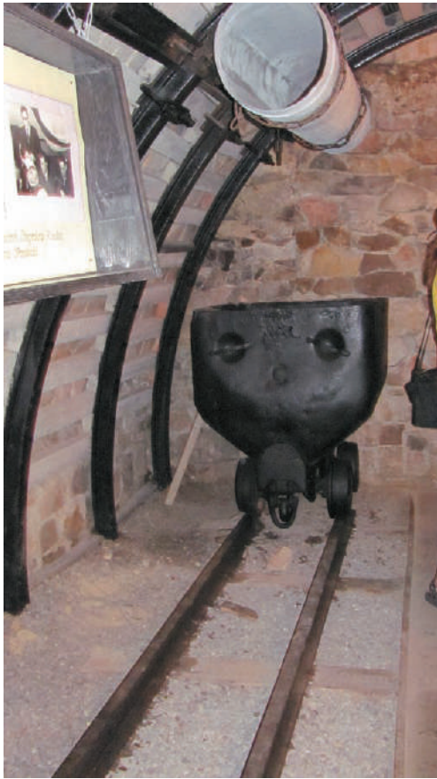
Fragment kopalnianego chodnika w oryginalnej obudowie...
