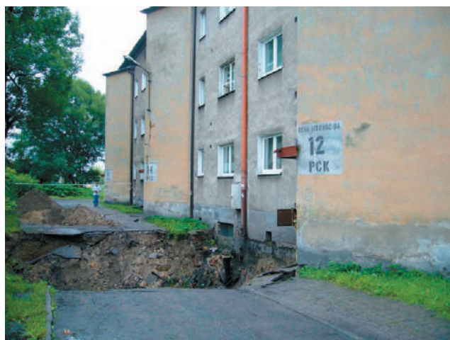
Rys. 10. Zapadlisko na terenie pogórnicznym kopalni „Siemianowice”
