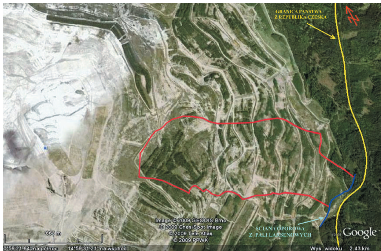
Rys. 4. Zdjęcie satelitarne obszaru osuwiska – stan aktualny po rekultywacji
