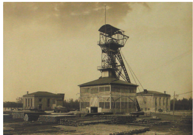
► Fot. 6. Kopalnia „Giesche”, szyb Wschodni
