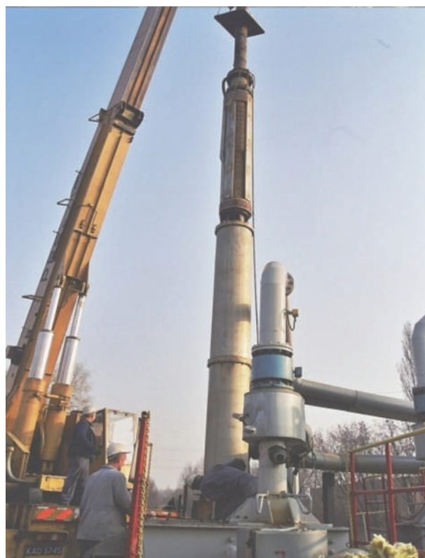
► Rys. 8. Osadzanie agregatu pompowego w szybie
