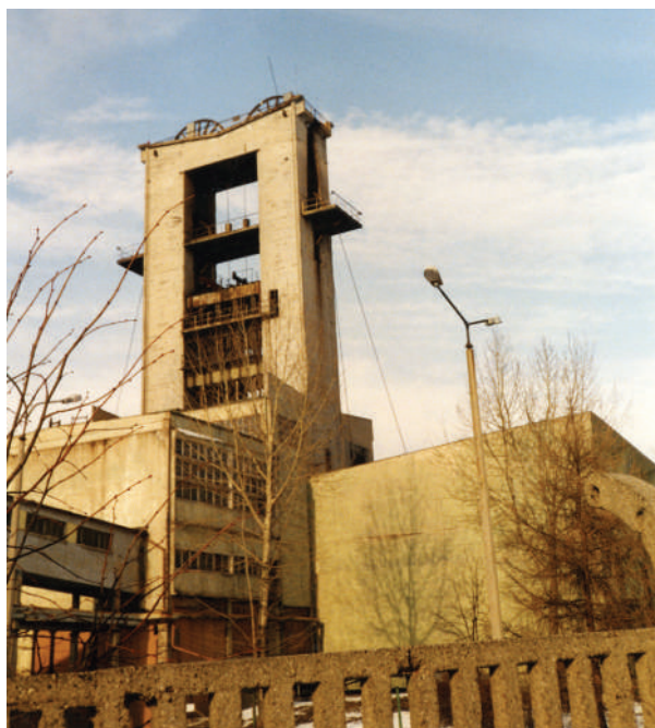
► Kompleks obiektów szybu Roździeński, kopalnia „Wieczorek”
