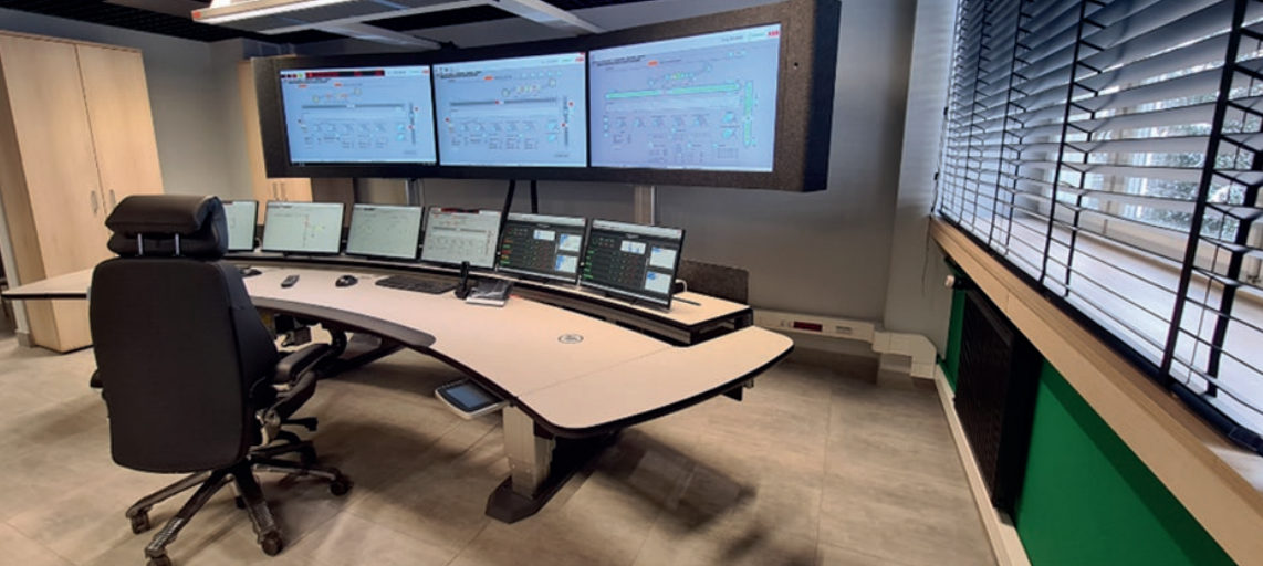
► Rys. 1. Stanowisko operatora systemu ABB 800xA w LW „Bogdanka” S.A.
