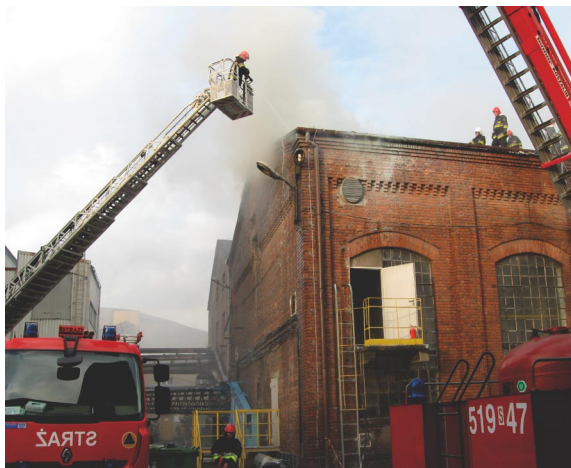
Fot. 4.3.4. Pożar budynku rozdzielni głównej w KWK „Bolesław Śmiały”
