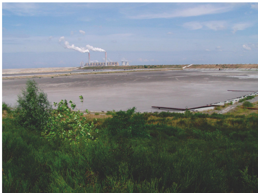
Fot. 2.11.1. Kopalnia Węgla Brunatnego „Bełchatów” – zbiorniki popiołów lotnych na terenie zwalowiska wewnętrznego (2008 r.)
