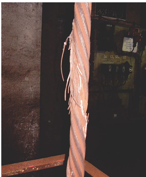
Fot. 4.3.3. Uszkodzenie liny nośnej będące powodem zatrzymania wyciągu szybowego w KWK „Bielszowice”
