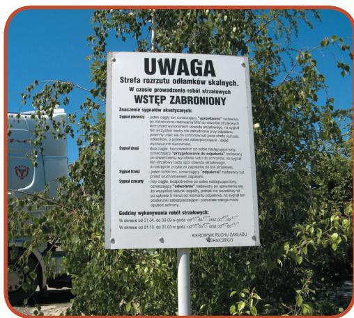
Fot. 2. Tablica zabezpieczająca strefę rozrzutu odłamków skalnych
