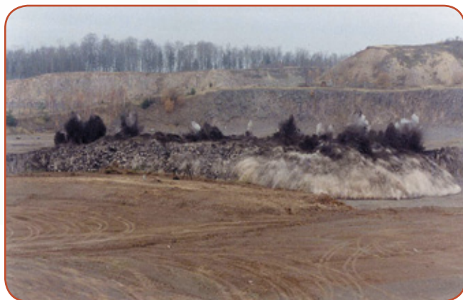
Fot. 1. Odstrzał ładunków MW z widocznym rozrzutem odłamków skalnych
