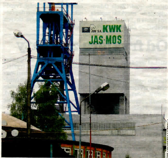
Pracownicy likwidowali ścianę na poziomie 850 metrów
