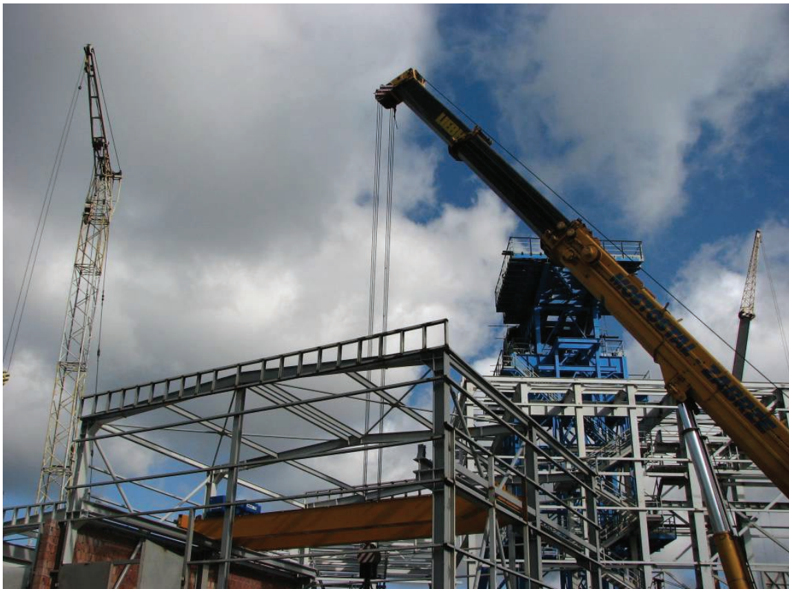
Fot. 4.1.1. Prace prowadzone w rejonie szybu Leon IV w KWK „Rydułtowy-Anna”
