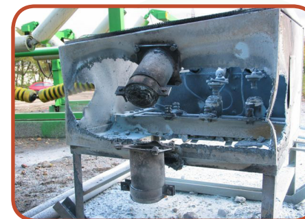
Brak stosowania sprzętu ochronnego
